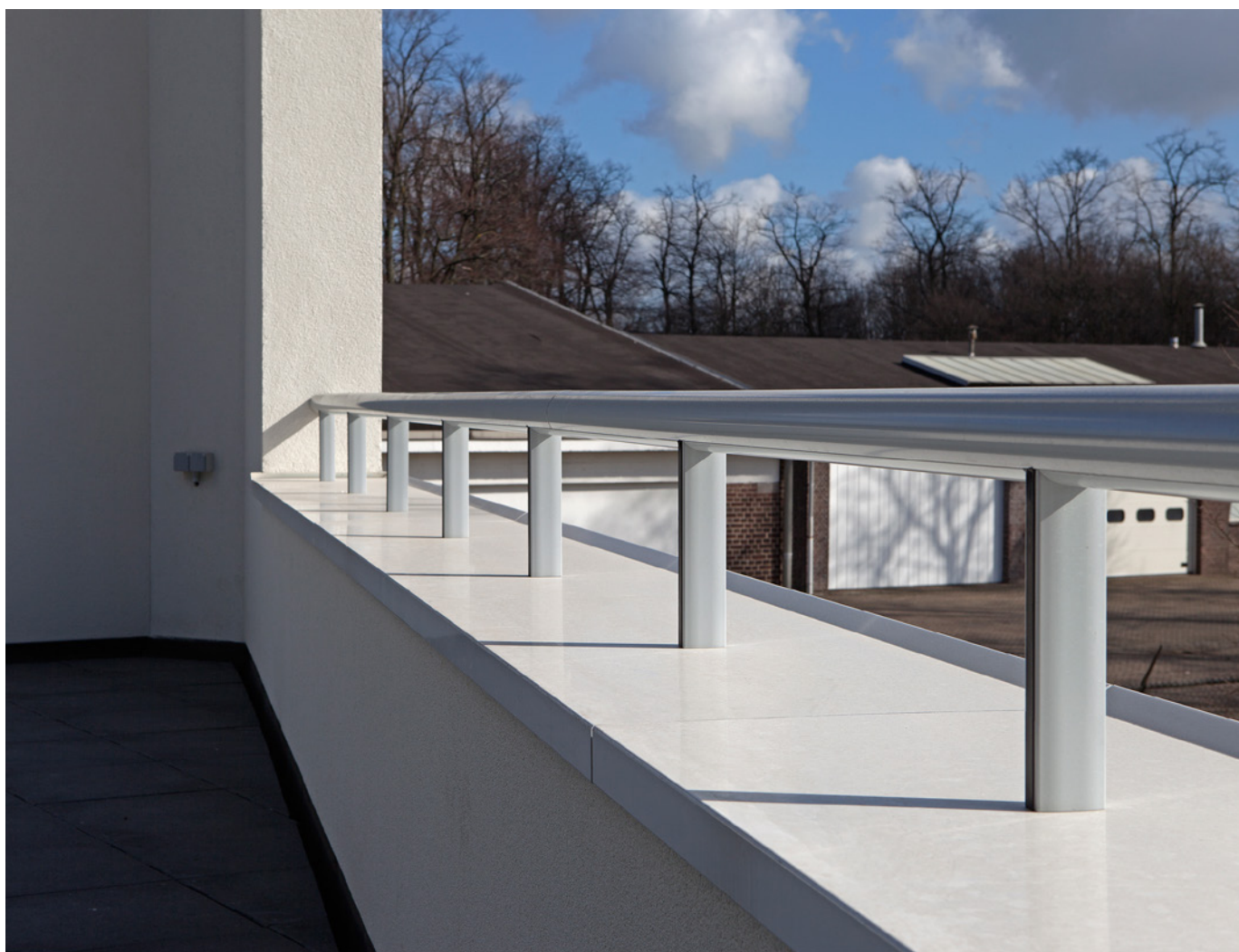
Het klanksysteem zorgt ervoor dat de aluminium muurafdekkap strak en glad blijft
