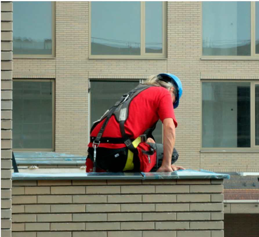
Slim klangensysteem zorgt voor snellere montage en bevordert de duurzaamheid van de aluminium muurafdekkap
