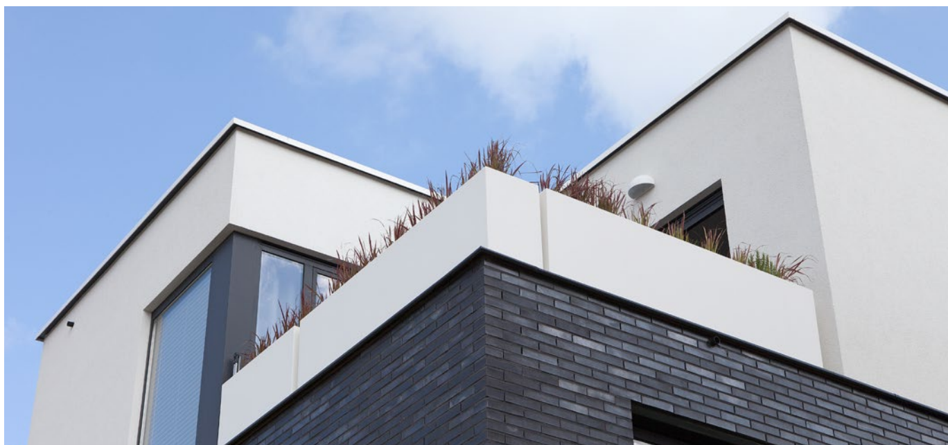
Aluminium dakranden accentueren overgang van gevel naar dak
