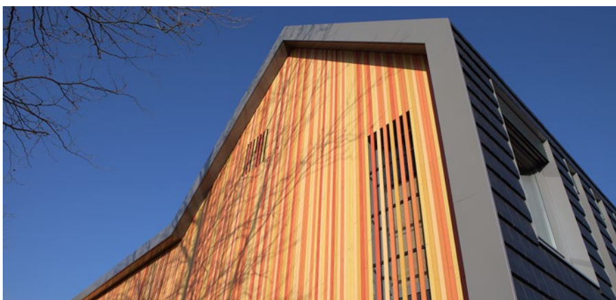
Aluminium muurafdekkappen op uniek klanksysteem voor schroefloze montage
