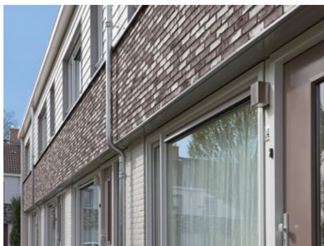
Budel, renovatie 69 woningen, aluminium maatwerk, waterslagen, doorvalbeveiliging en dagkanten
