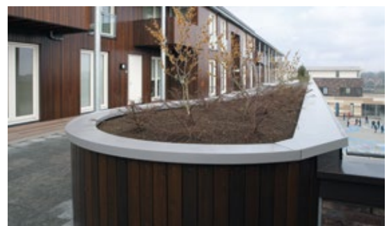
Reeuwijk, MFA De Oude Tol, aluminium maatwerk in vorm van muurafdekkingen, waterslagen en dakranden
