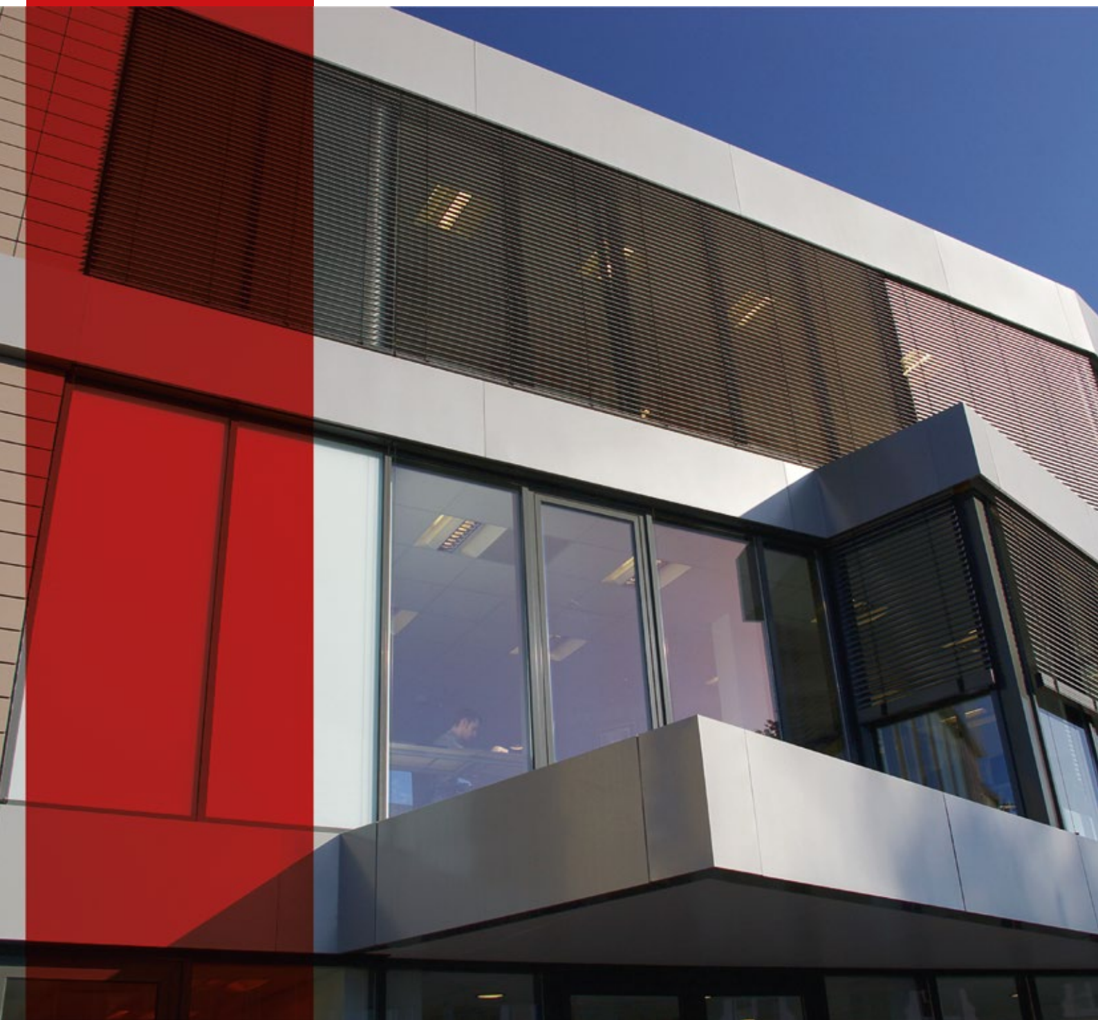
Bedrijfspannd Hobij Groep (renovatie), Veghel, aluminium maatwerk, overstekbekleding, boeiboorden en muurafdekkappen
