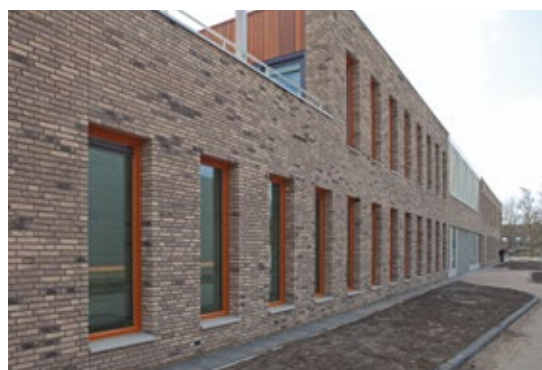
Leidschendam, GGZ Haagstreek, aluminium waterslagen en muurafdekkappen met balusters
