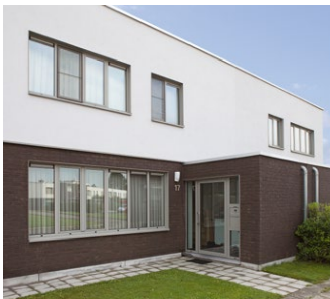
Mechelen, woningen Mahatma Gandhi, aluminium scheidingsprofiel, waterslagen, dagkantprofielen, dakranden en muurafdekkappen (schoorsteenbekleding). Aluminium kozijnen geleverd door moederorganisatie Reynaers Aluminium
