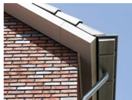
Someren, CPO woningen Waterdael, aluminium goot- en overstekbekleding
