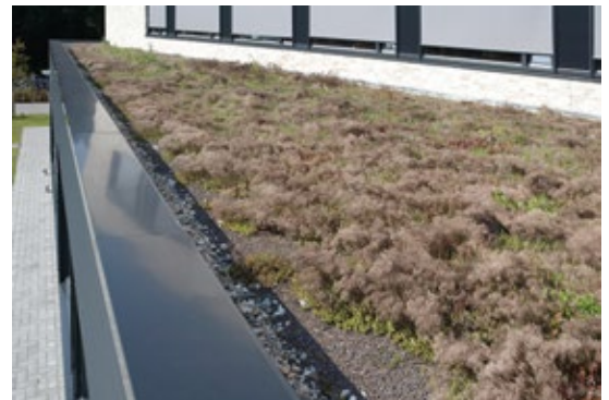
Valkenswaard, Were Di, aluminium muurafdekkingen met groendak en waterslagen
