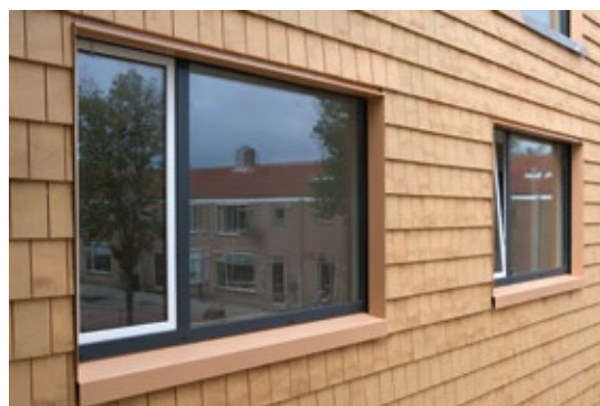
IJmuiden, Zorgcentrum Velsersduin, aluminium dagkanten, gezette waterslag, maatwerk en muurafdekkappen
