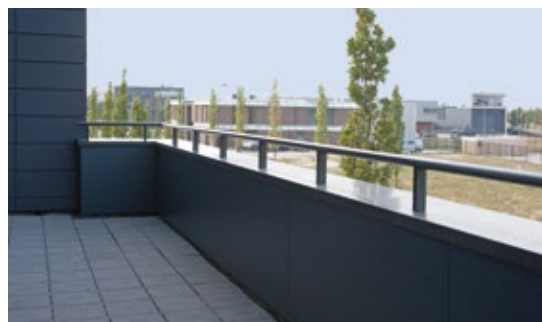
Tilburg, bedrijfsgebouw ISAH, aluminium muurafdekkappen met aluminium balusters
