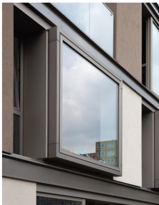
Amsterdam, Laan van Spartaan, aluminium boeiboorden en kozijnomkadering, brons geanodiseerd
