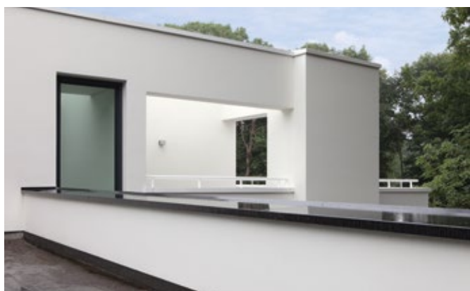
Breda, particuliere woning, aluminium in combinatie met stucwerk, balusters, muurafdekkappen en waterslagen
