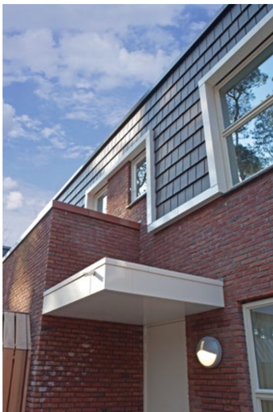
Oisterwijk, De Hondsborg, aluminium dagkanten, luifelbekleding en dakranden
